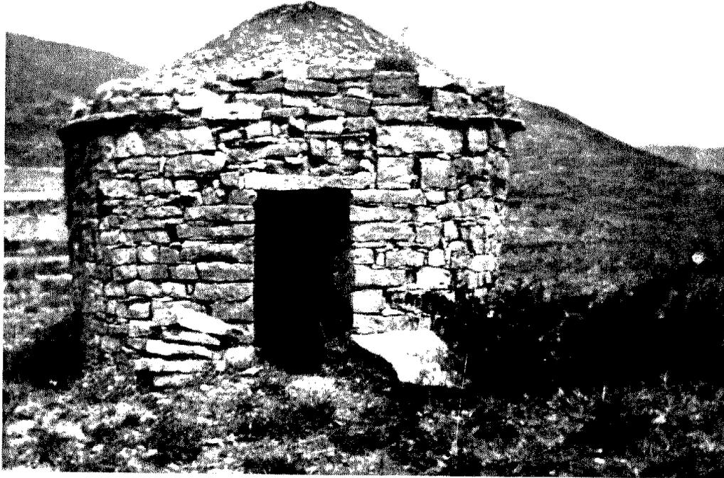
*Fig. 1. Barraqueta de pinça de Els Rocaus, de cúpula cónica y planta cuadrada.*
