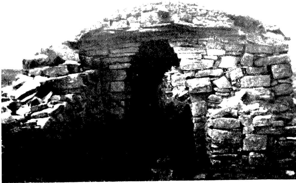
*Fig. 1. Barraca empotrada en un marjal, de planta cuadrada y provista de hogar y escape de humos en forma de chimenea. Caso no muy frecuente en el grupo de Els Rocaus.*
